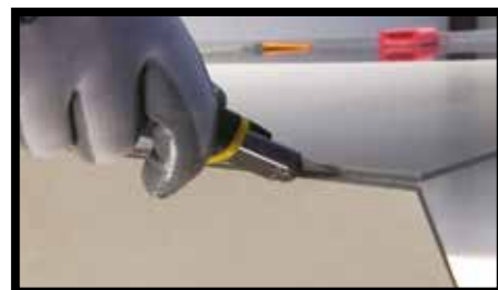
Fig.4 - Per SLIMTECH 3PLUS e SLIMTECH 5PLUS, una volta incisa la parte ceramica e spezzata la lastra, si rifinisce il taglio incidendo la fibra di vetro con un normale cutter.
