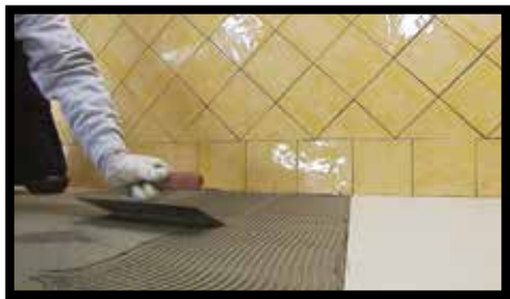
Fig.28 - Questa tecnica è indicata esclusivamente con gli adesivi che nella scheda redatta dal loro produttore riportano la dicitura “posa con spalmatura singola”. Stendere l’adesivo a letto pieno sulla superficie del supporto. Seguire le indicazioni del produttore dell’adesivo per quanto riguarda tipologia di spatola e modalità di stesura.
