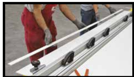
Fig.5 - Un pratico strumento per eseguire i tagli risulta essere la riga tagliapiastrelle (tipo Keracut della Sigma o Free-cut di Raimondi ). Per SLIMTECH 3PLUS e SLIMTECH 5PLUS, anche utilizzando questo strumento, una volta incisa la parte ceramica e spezzata la lastra, si rifinisce il taglio incidendo la fibra di vetro con un normale cutter ( Fig.4 ).
