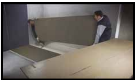
Fig.31 - Vanno movimentate portandole prima in posizione verticale sostenendole per il bordo superiore, quindi muoversi mantenendole sempre rettilinee con l’aiuto di una seconda persona.
