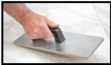
Fig.30 - Una volta posata la lastra occorre far aderire la colla in ogni suo punto evitando così la formazione di vuoti e bolle d’aria. A questo scopo si devono utilizzare frattazzi gommati (ad esempio Raimondi “142G”).
