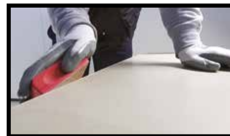
Fig.12 - Le finiture dei bordi possono essere effettuate a mano tramite l'utilizzo di spugne diamantate o carta vetrata. Con un leggero passaggio sul lato della lastra si può ottenere un effetto rompicello, oppure con ripetuti passaggi un effetto bisello.
