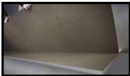
Fig.32 - Vanno posate appoggiando uno dei lati lunghi e quindi accompagnandole sul supporto.
